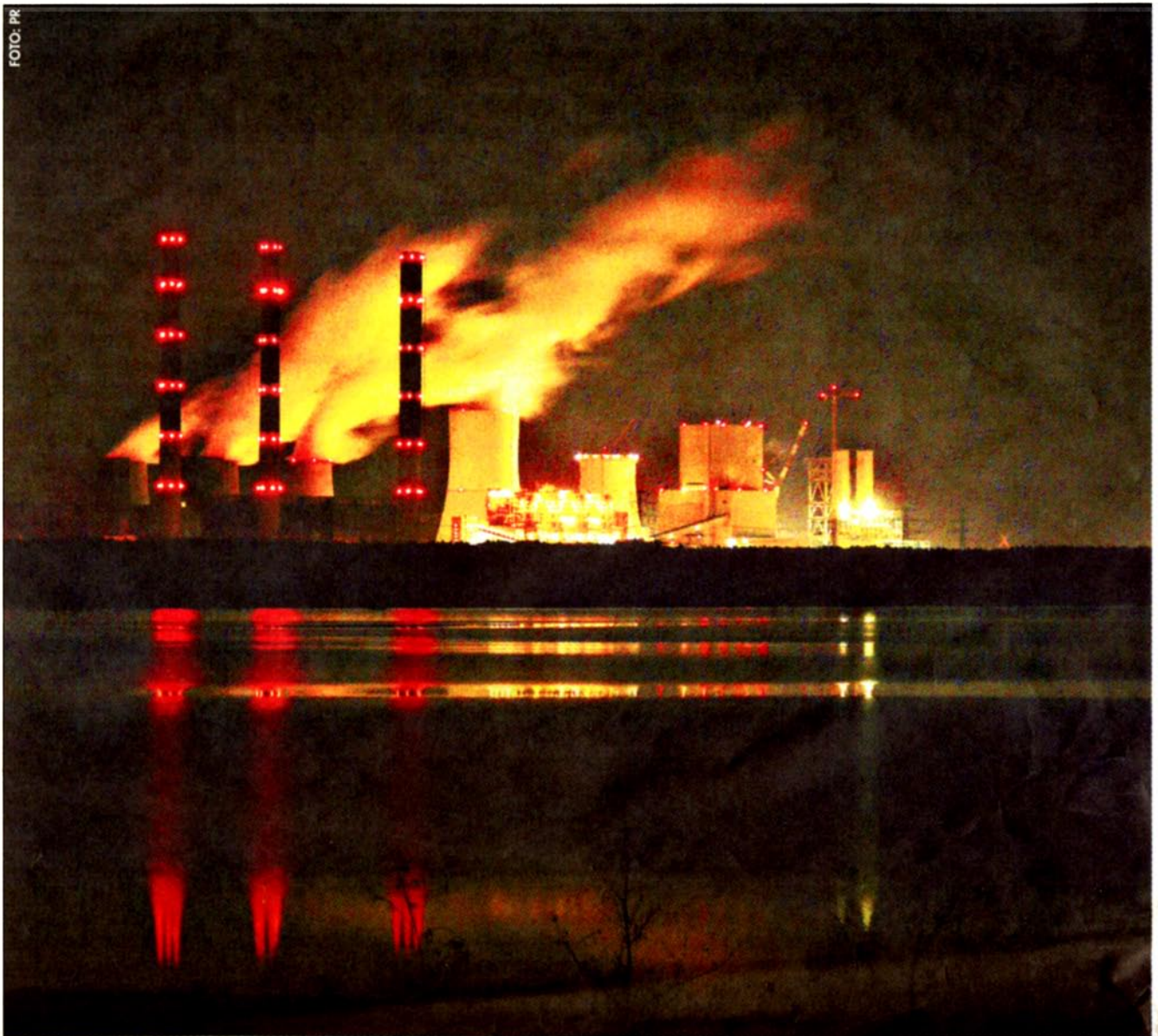
Das Kraftwerk Boxberg bestimmte in den achtziger Jahren über die Landschaft der Oberlausitz. Nun ist es ein „Kunstobjekt“
